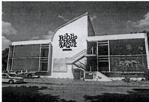
Descrição: Vista geral pela lateral do imóvel.
